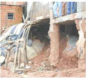
Quando após uma forte chuva começar a aparecer as sapatas da casa, muro ou construção, devem ser feitas as contenções emergenciais o mais rápido possível antes que entre em colapso
