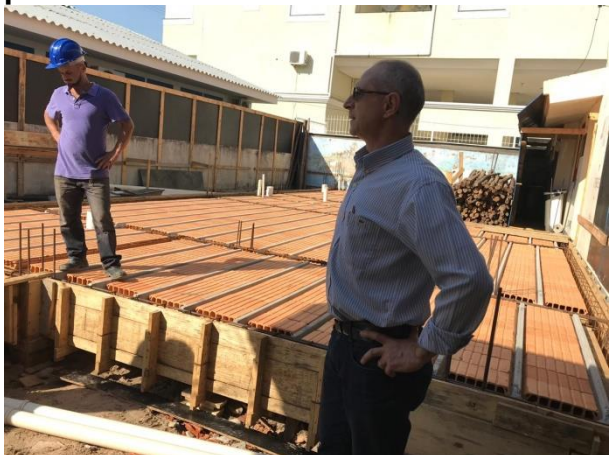
Obras do Núcleo de Educação Infantil Jurerê
