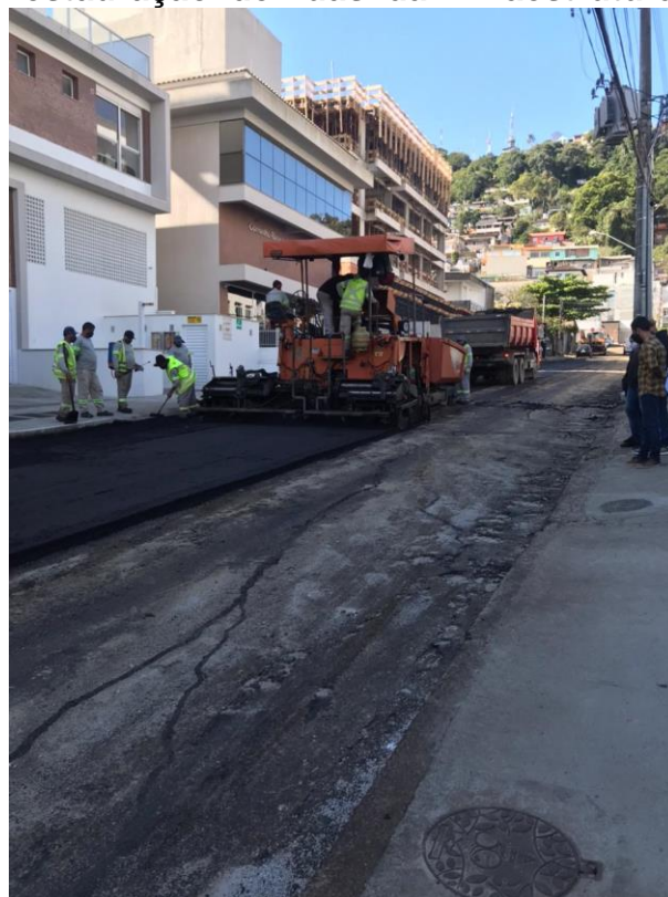
SMTAC visita obras de ruas do município
