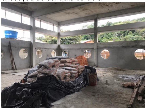
SMTAC monitora obras da EBM Jurerê
