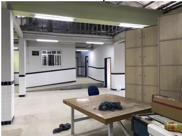
SMTAC visitou as obras no Córrego Grande
