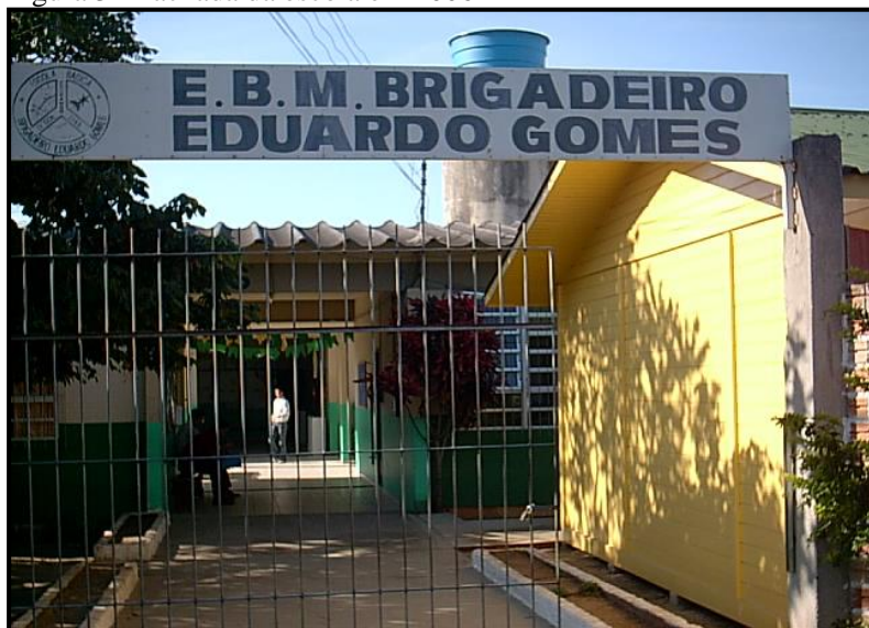
Figura 3 - Fachada da escola em 2006
