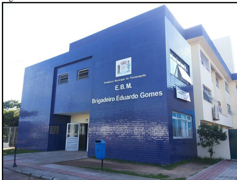
Figura 4 - Fachada da escola em 2014
