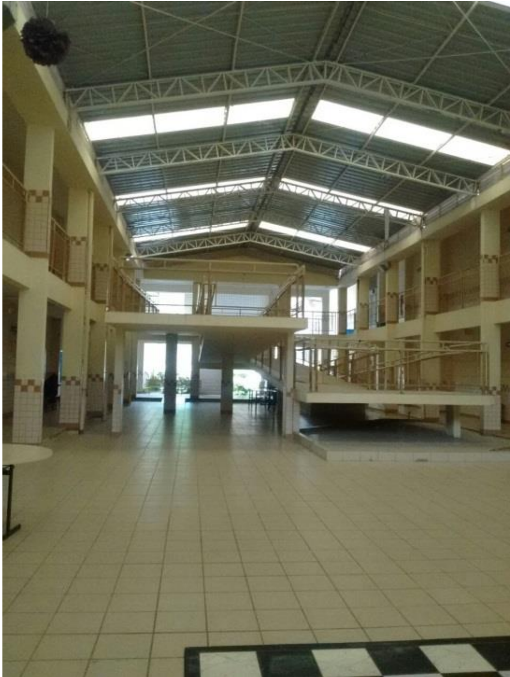
Foto 9: Entrada principal (parte interna) da escola III
