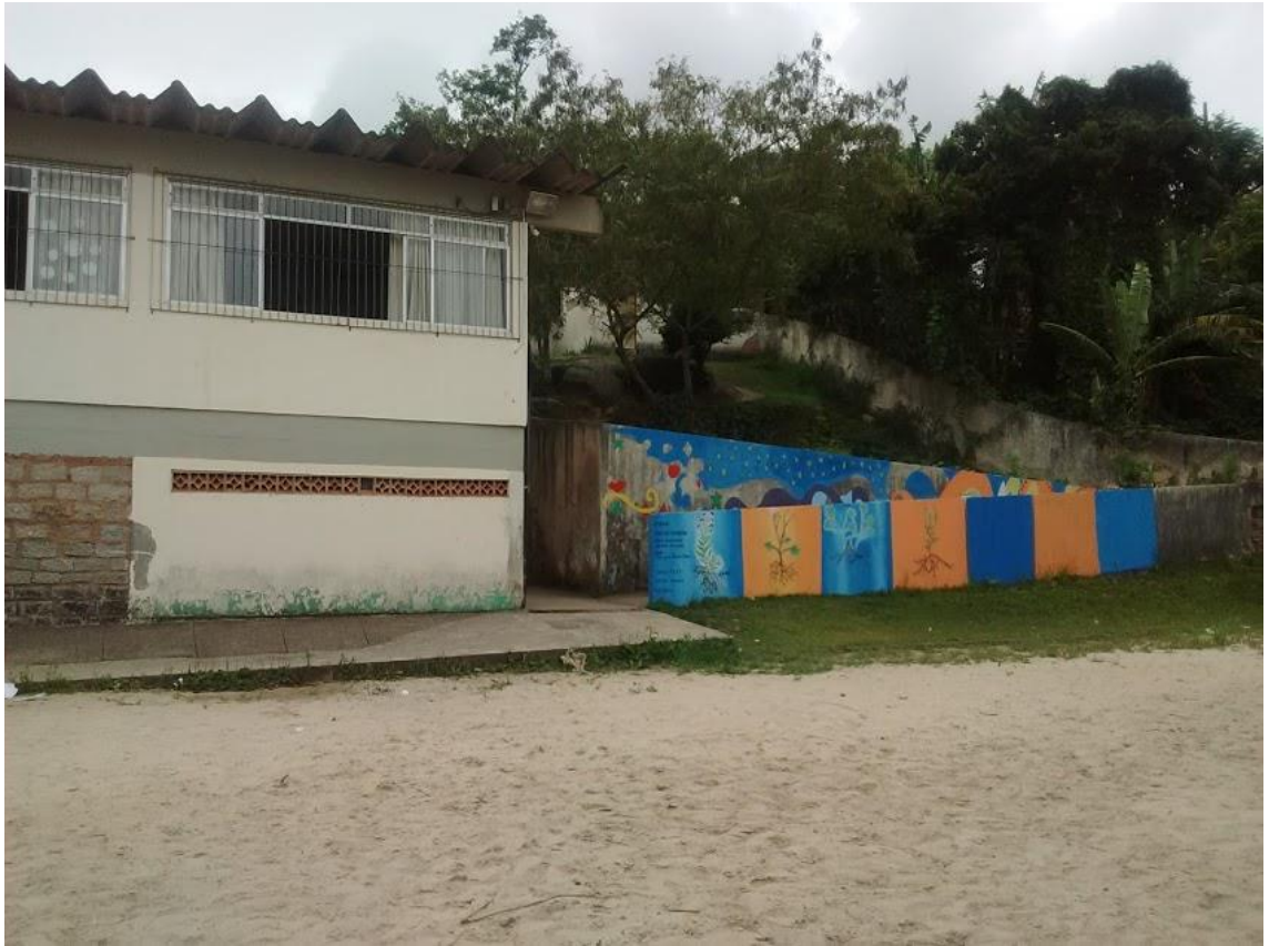
Foto 6: Monitoramento da rampa de acesso para deficientes
