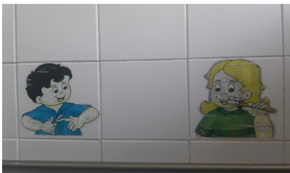
Figura 11 - O interior do Banheiro 1.
