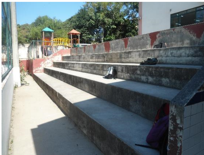
Figura 2 - Arquibancada, em concreto. EB Maria Tomázia Coelho. (Fonte: Pesquisador)
